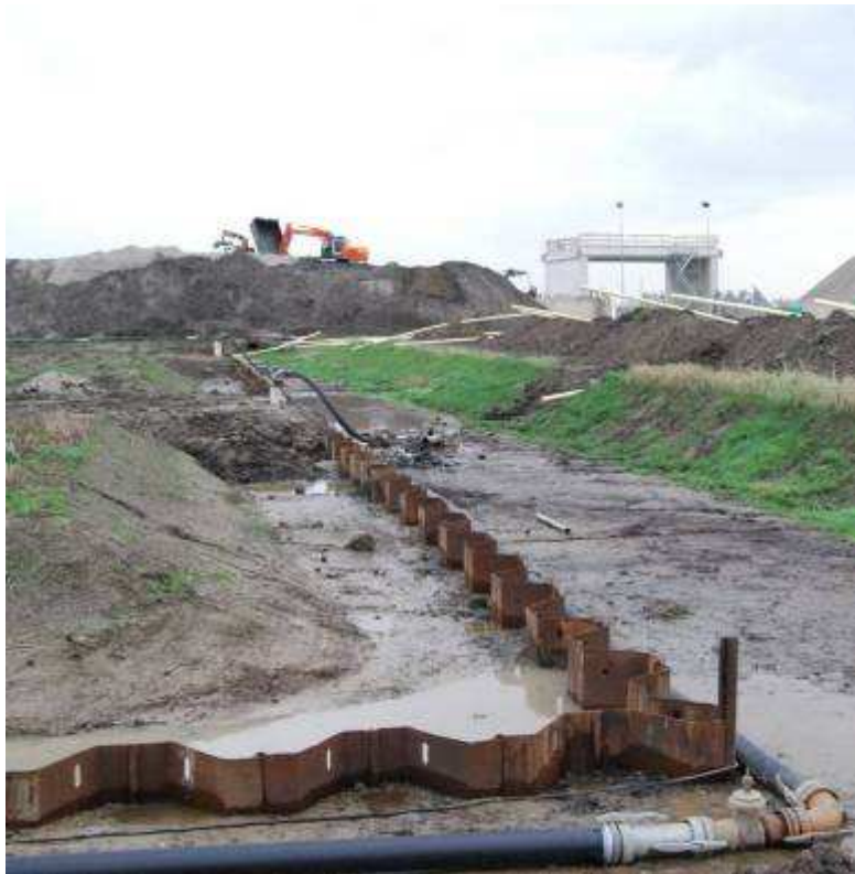
9,5 m deep sheet pile wall
